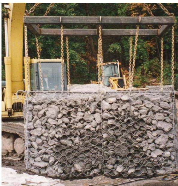
1.22 Количество комплектов стержней определяется по месту, исходя из производительности процесса заполнения габионов. Для предотвращения деформации габионов в процессе монтажа предусматривается использование специальной траверсы имеющей не менее десяти точек цепных или тросовых подвесов по пять вдоль каждой длинной стороны габиона и изготовленной из металлического профиля балки или швеллера №14 и т.д. Размер траверсы равен 2000х1000 мм, что соответствует размеру габиона в плане.
