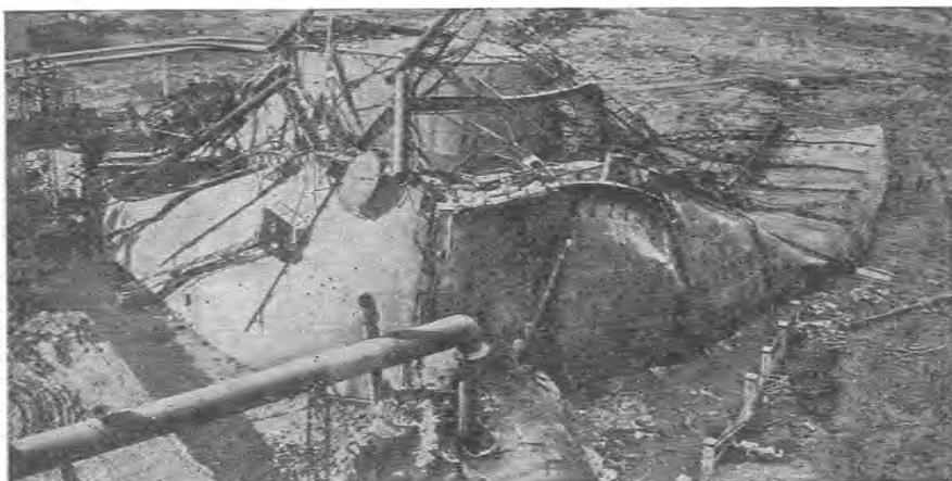
Рис. 31. Общий вид обрушившихся стальных конструкций газгольдера.
