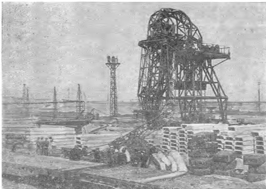
Рис. 49. Обрушение башенного крана на складе строительных конструкций.
