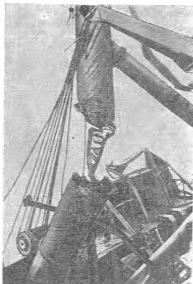
Рис. 43. Разрыв левой стойки стрелы надстройки экскаватора.
