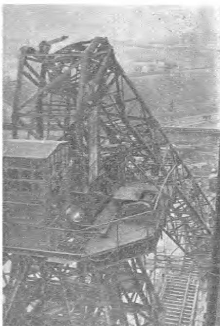
Рис. 51. Авария башенного крана на разгрузке металлоконструкций.
