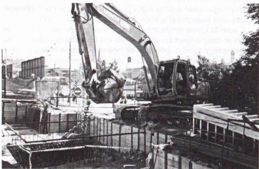
Рис. 1.41. Разработка грунта из-под перекрытия
