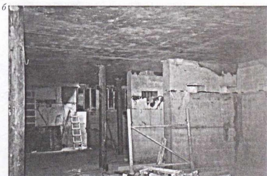
Рис. 1.42. Бетонирование стен первого этажа (*a*) и подвала (*б*) нового корпуса МГКГ А. Шилова
