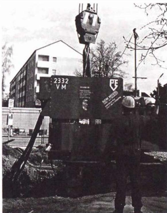
Рис. 4.13. Безрезонансный вибропогружатель PVE 2332VM
