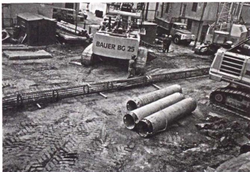
Рис. 1.30. Обсадные трубы и арматурный каркас буронабивных свай  $\varnothing 800$  мм
