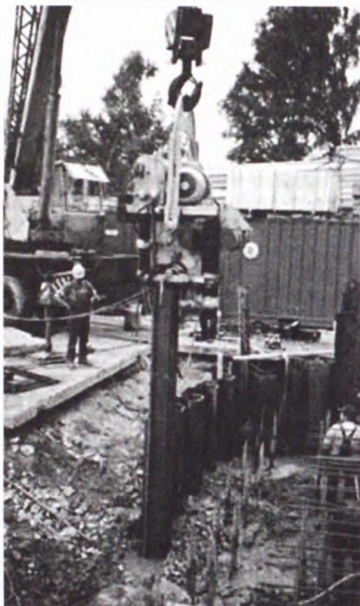
Рис. 1.4. Погружение шпунта типа «Ларсен» вибропогружателем
